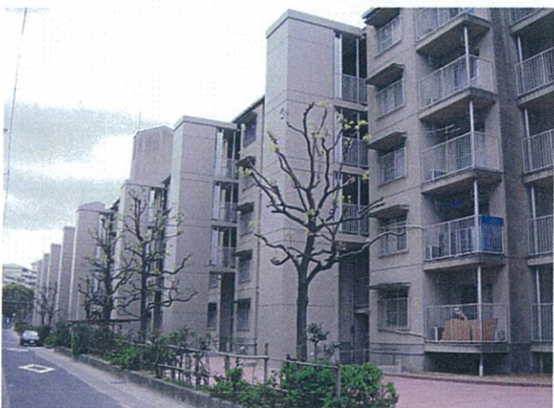
神戸市内O団地(8基)
