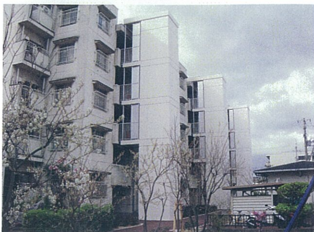
堺市内U団地(5基)
