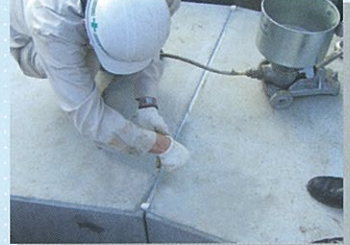
上部より頂版天端部へ注入(曲線部)
