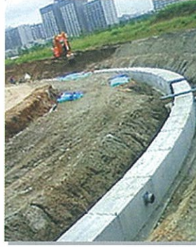
製品寸法: 800 × 800 × 2000, 600 × 600 × 2000, 500 × 500 × 2000 曲線施工
