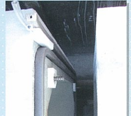
TBジョイントバー挿入状況
