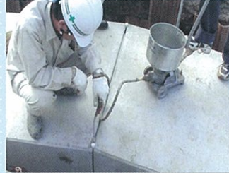
注入口より側壁部・底版部へ注入(曲線部)
