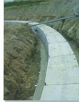
製品寸法: 800 × 800 × 2000, 600 × 600 × 2000, 500 × 500 × 2000 曲線施工
