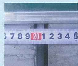
継手間隔 15mm (軸方向変位量10mm)
