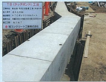
曲線部も直線部と同じ施工!
