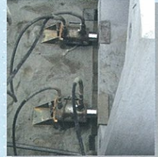
ジャッキによる押込み状況
