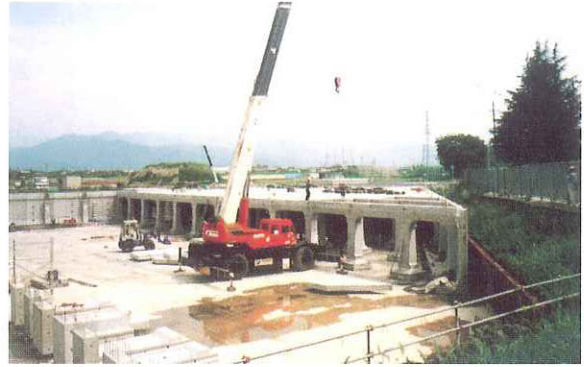
組立作業状況
