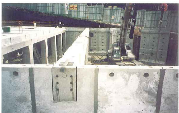
梁据付け状況
