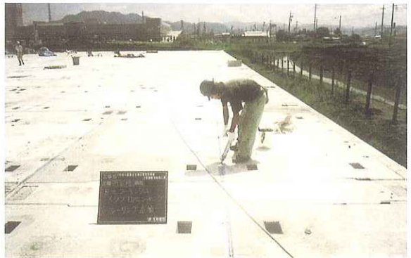
組立完成状況
