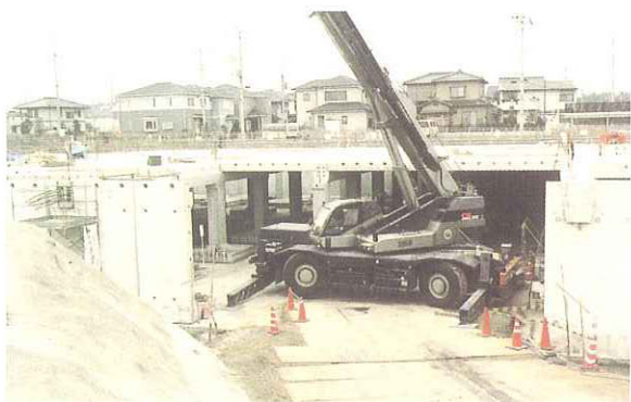
組立作業状況
