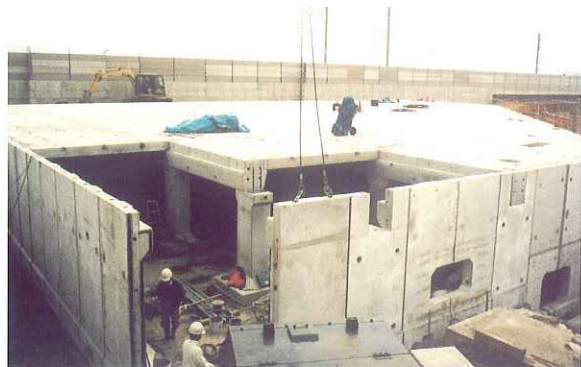
組立作業状況
