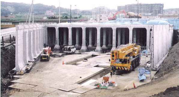
組立作業状況
