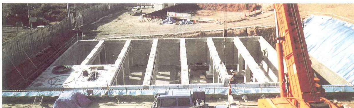
梁据付け状況
