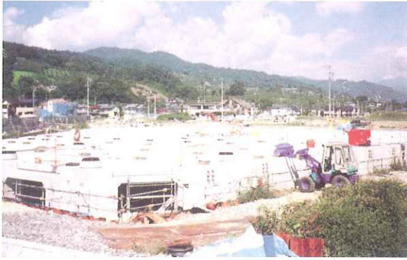
組立完成状況
