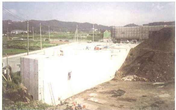
組立完成状況
