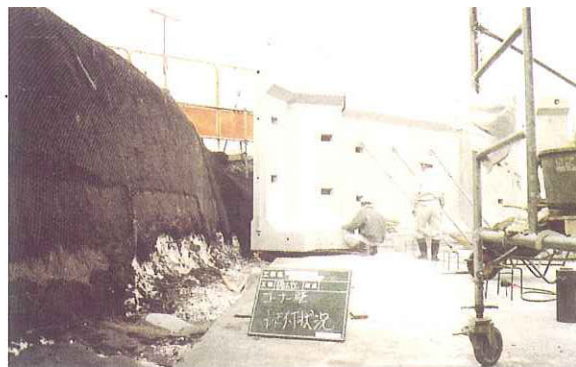
コーナー壁据付け状況
