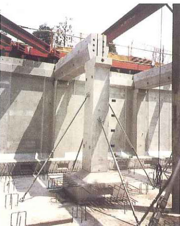
柱・梁据付け状況
