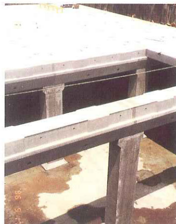
頂版スラブ据付け状況
