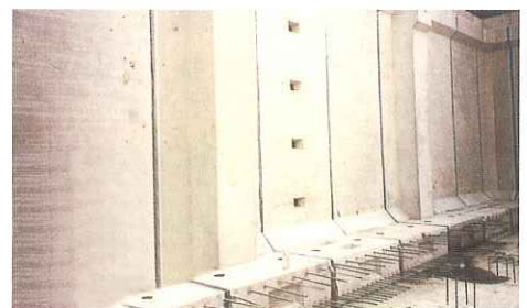
壁据付け状況
