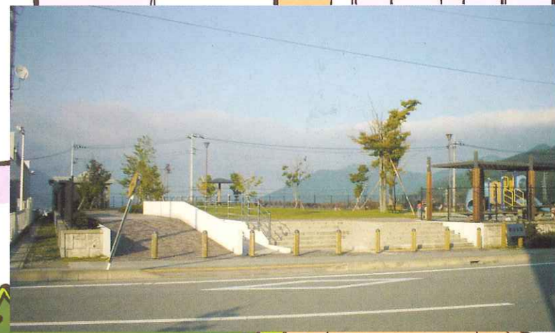
上部が公園の施工例
