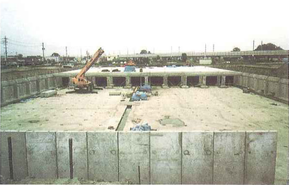
組立作業状況
