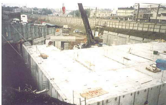
頂版スラブ据付け状況
